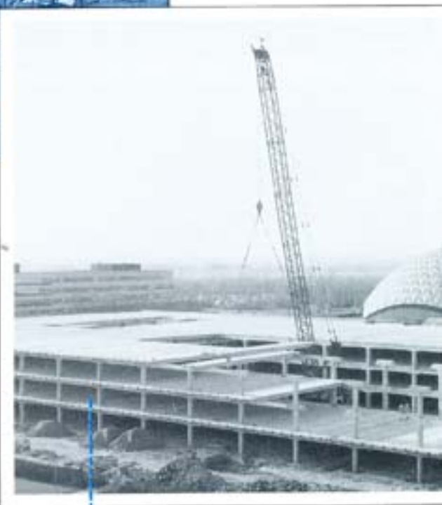
Een Mammoet crawler kraan op de luchthaven Schiphol hijs beton elementen voor een parkeergarage.
